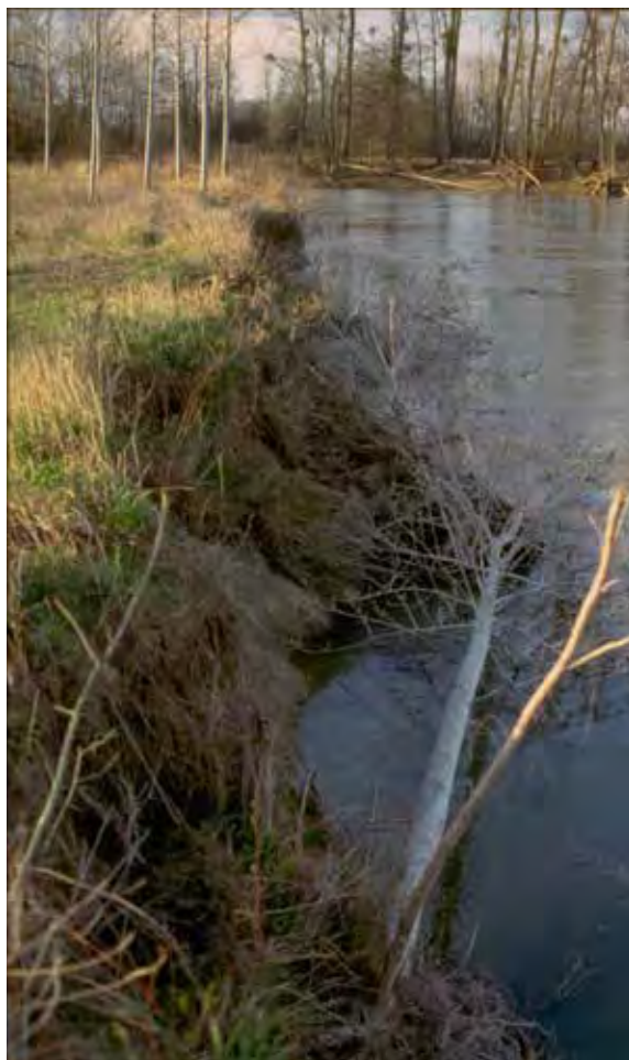
Figure 21 – Érosion de berges, un aspect sensible à d'éventuels changements de régime des eaux
