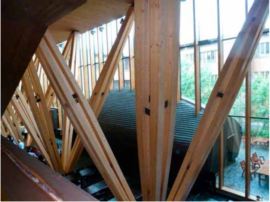
Figure 42 – Bâtiment moderne en bois : Institut de recherche forestière de Joensuu (Finlande)
